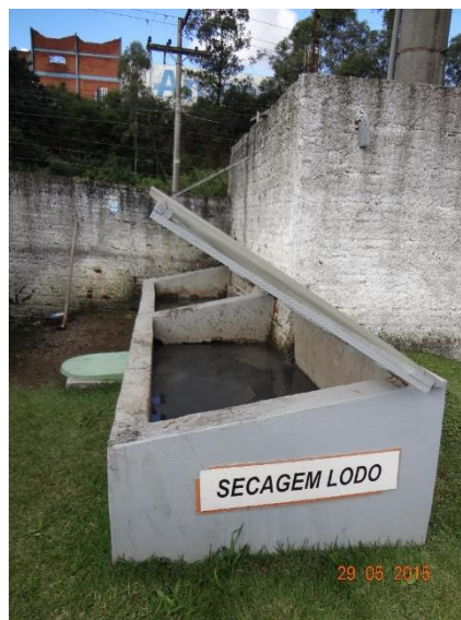
Figura 7 – Leito de secagem
