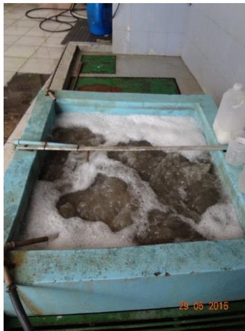
Figura 4 – Caixa de tratamento do efluente
